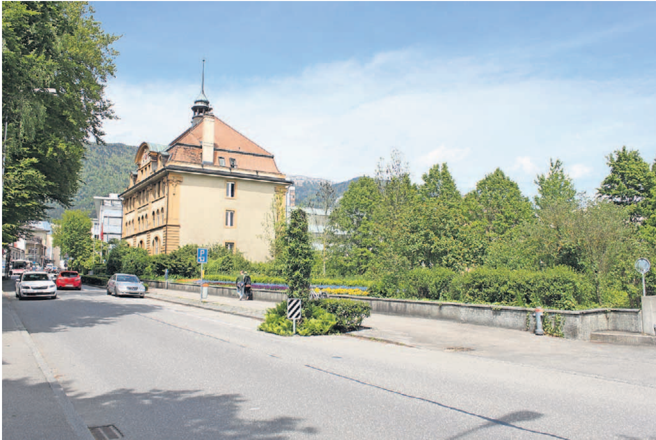
Auf diese Parzelle südlich des Stadthauses soll das neue Verwaltungsgebäude zu stehen kommen.
