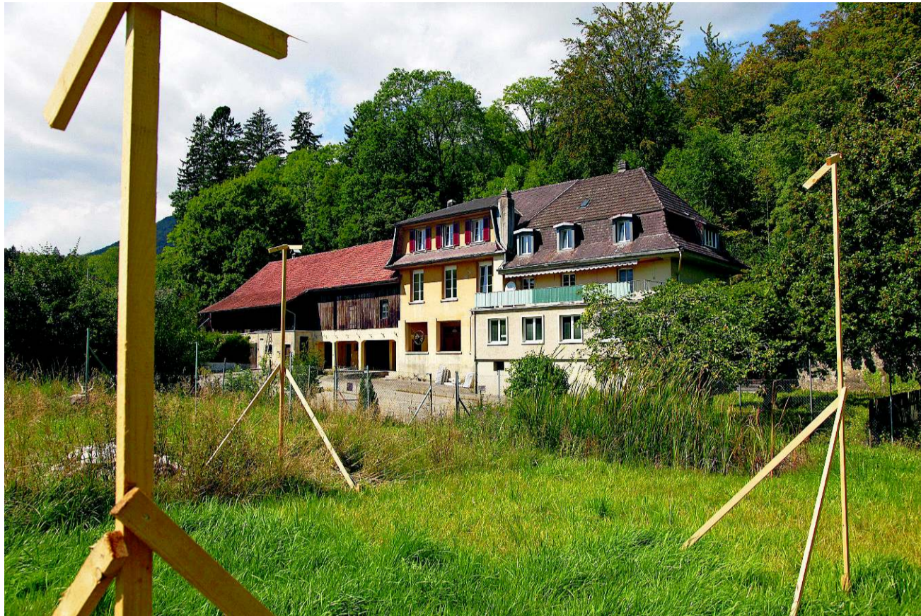
Die Bauprofile für den neuen Hühnerstall sind erst der Anfang – das «Chappeli» eröffnet 2012. HANSPETER BÄRTSCHI
